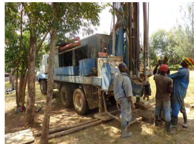
De boormachine precies boven het boorgat, dat het begin is van de 135 meter diepe reis naar het grondwater
