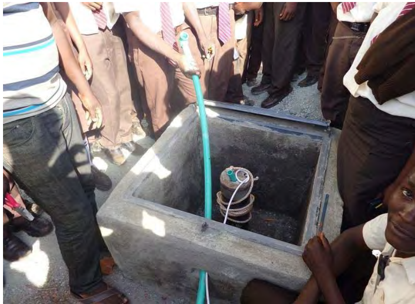
De elektrische pomp die verbonden wordt met de groene slang waardoor het grondwater naar boven wordt gepompt
